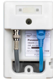
写真左：同軸ケーブル 写真右：LAN ケーブル
