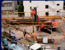
工事・建設現場
