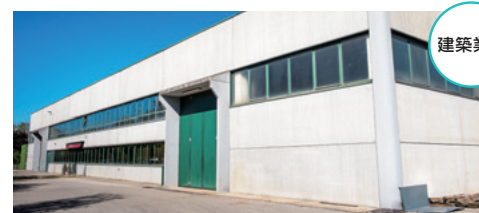
建物外壁点検時のひび割れの長さ測定など
