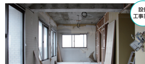
設備入れ替え時の現場調査での対象物の長さ測定など
