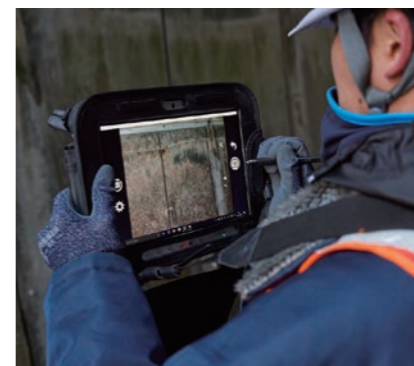
FZ-G1の内蔵カメラで変状を撮影。デジタルカメラを持ち歩く必要がなくなり、データ整理の手間も削減。
