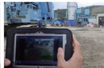
▲スナップショット機能を使用すれば、撮影した現場を杭工事記録システム現場検査マスター@に取り込むことができる
