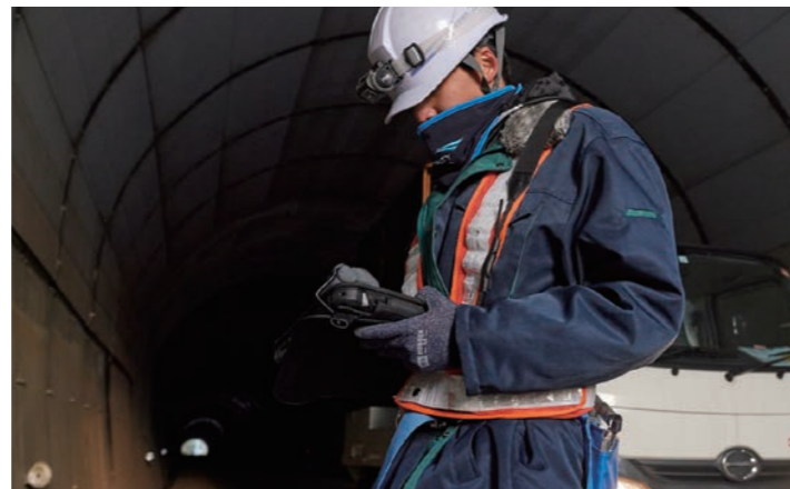
トンネル点検業務でFZ-G1とインフラ点検レポートサービスを使用。従来、変状の記録に使用していたA3サイズの野帳と比べコンパクトで機動性があり、タッチペンでの記入もスムーズと好評。
